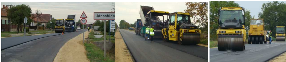
1. ábra AC11 kopó aszfaltréteg építés a 3121. jelű úton Jász-Nagykun-Szolnok megyében
